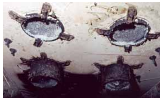
Photo D - Système de colliers intumescents encastrés ou en applique en dalle - Après essai, vue de l'intumescence à l'intérieur des colliers
